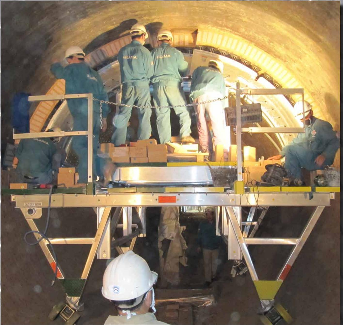
**Incrementar la rapidez de instalación y mejorar la calidad y la seguridad son los objetivos principales de nuestros equipos. Nuestra cercha de instalación puede incorporar, la mayor plataforma de trabajo del mercado (5,2m de largo). El sistema de doble arco se ajusta en 10 minutos para solventar cualquier distorsión del horno. Nuestra válvula maestra de tres vías (una para cada arco) permite que cada uno de los cilindros de cada arco sea conectado de forma individual o múltiple.**
