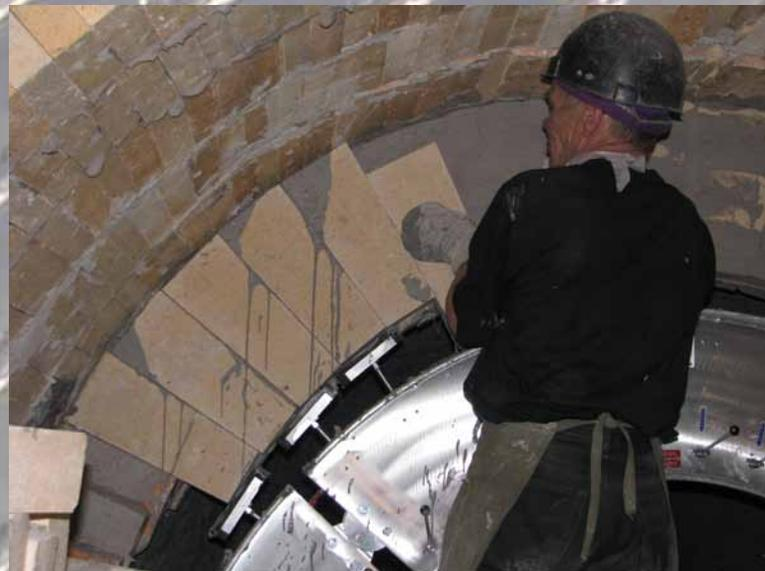
**Guarde la Máquina de ladrillos personalizada para cazos Torpedo reemplaza la antigua cuña y forma de madera. Reduce el tiempo de configuración e instalación. Arco flexible personalizado con conexiones de bisagra flexibles que permiten que las alas del arco se adapten hacia y lejos de la pared del horno. Poste estabilizador de arco para adaptar la distancia adecuada al arco desde el armazón. Carro del arco que soporta el arco y se mueve a lo largo de la plataforma.**
