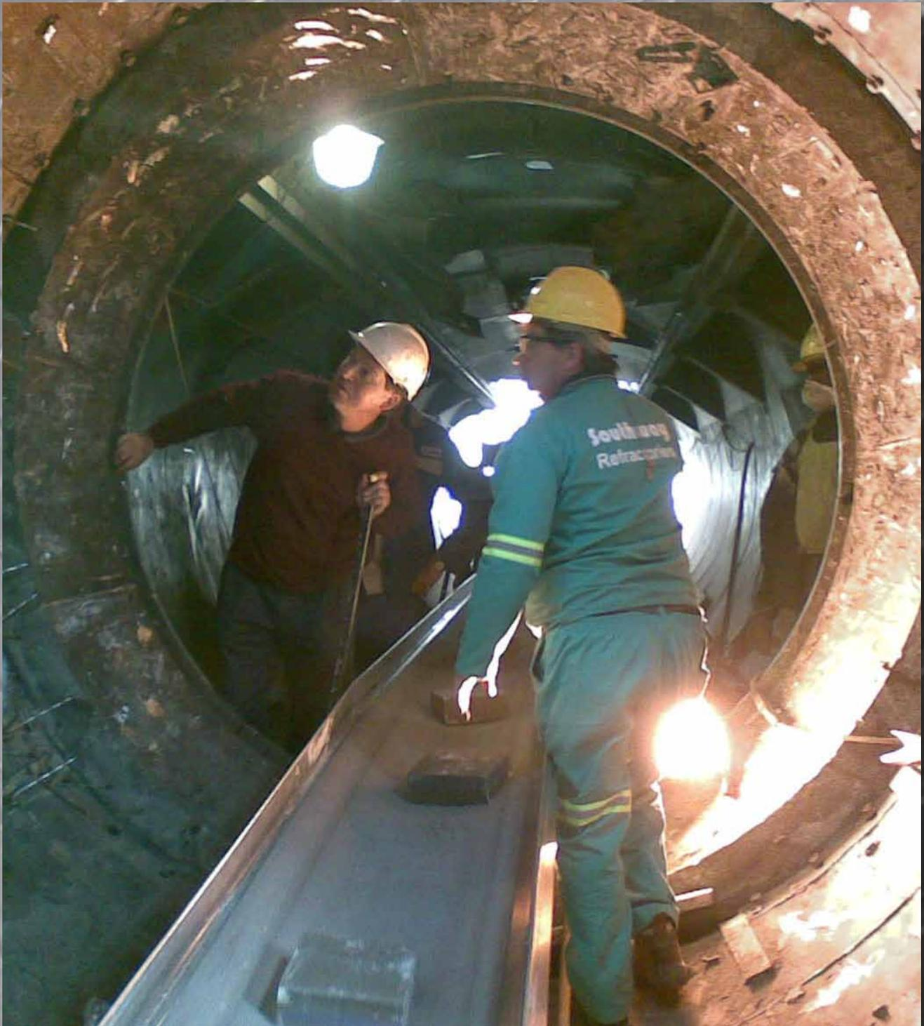
**El transporte de material dentro y fuera del horno es un punto clave para la rapidez del proceso de mantenimiento. Las cintas transportadoras reducen la fatiga de los operarios, además de evitar pérdidas de tiempo y minimizar los riesgos. Fabricadas en aluminio ligero con motores hidráulicos, las secciones de la cinta se manejan y montan con mucha facilidad.**
