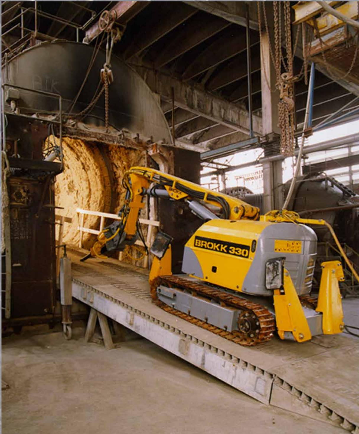
Utilizar una rampa de acceso para los robots de demolición Brokk ofrece una demolición de refractario más rápida, segura y precisa que con otros métodos. El sistema de control remoto permite que el trabajador permanezca a salvo de vibraciones y desprendimientos. Al tratarse de un equipo eléctrico, Brokk elimina los riesgos de los humos peligrosos y proporciona un área de trabajo segura.
